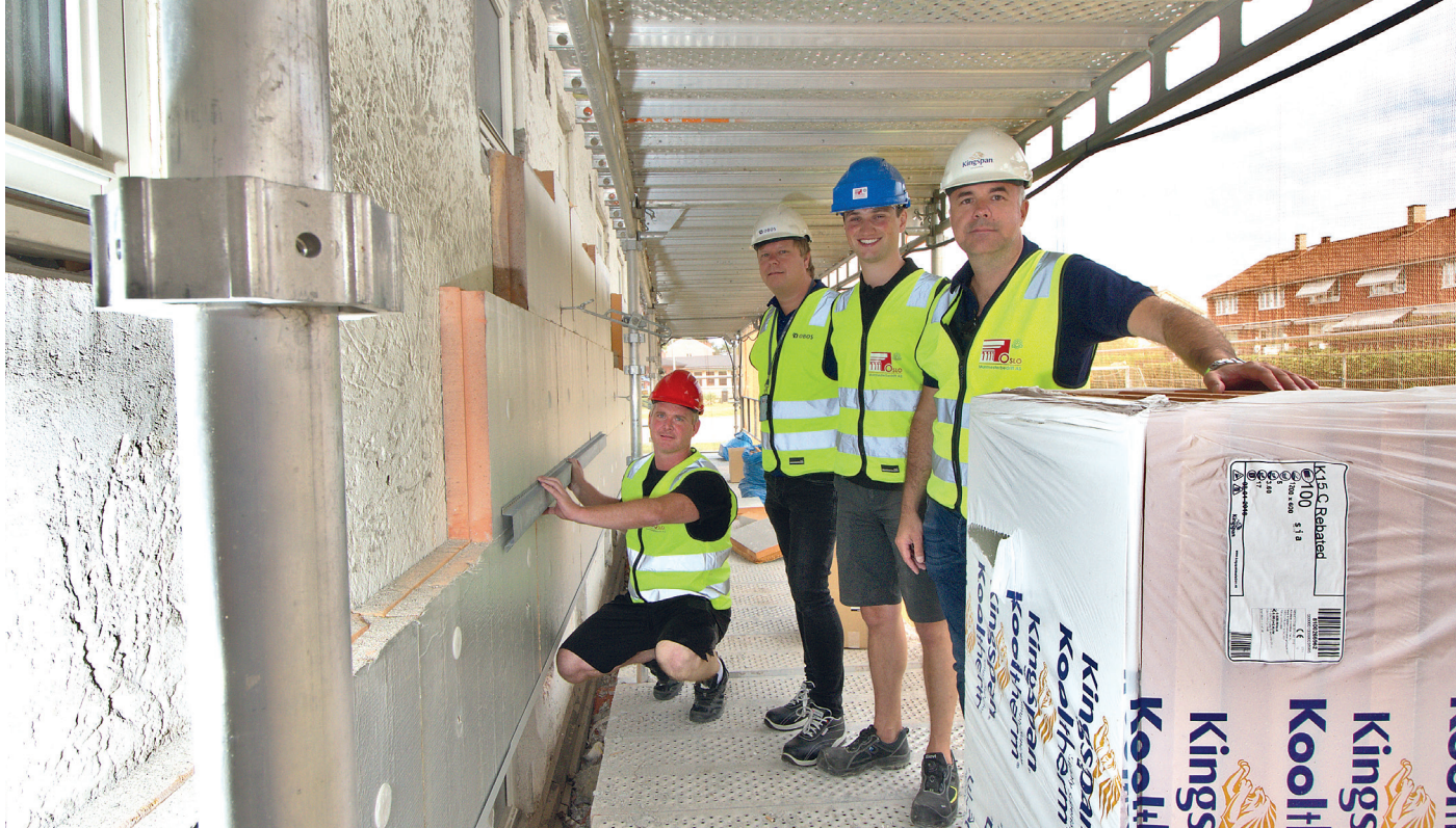
ISOLERT SETT. Harald Øygarden i Oslo Murmesterbedrift (fra venstre), Vidar Frydenborg i OBOS Prosjekt, Torbjørn Nordal i Oslo Murmesterbedrift og Geir Rotvik i Kingspan er alle godt fornøye med fasadeisolasjonen valgt i rehabiliteringen av Mangleud Borettslag i Oslo.
